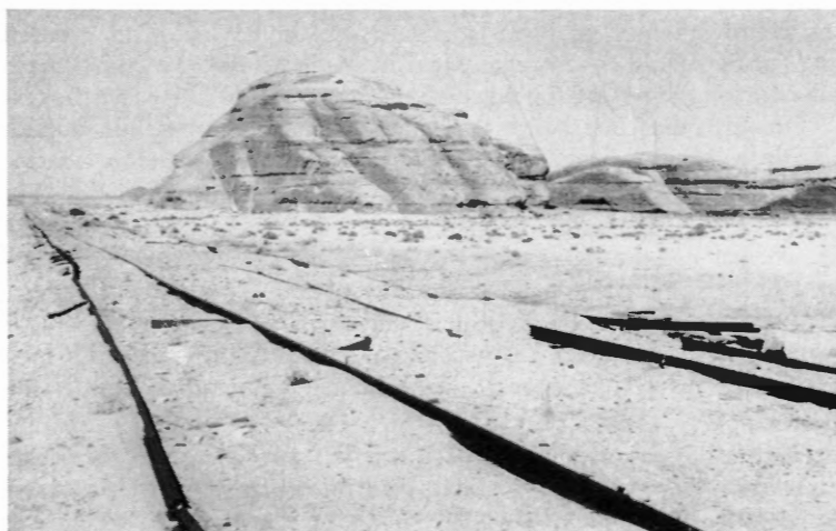
Bild 5: Durch Erosion und Korrosion stark zerstörter Streckenabschnitt bei Abu Taka.
